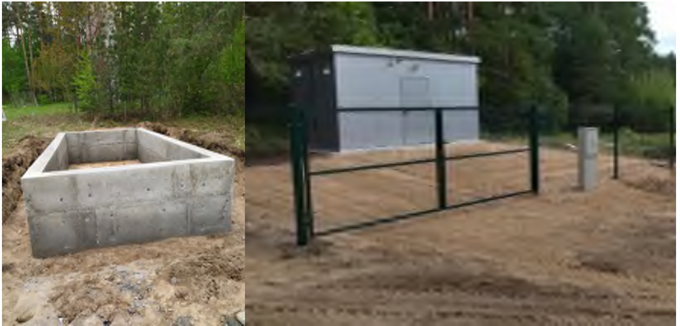
33 pav. Tolkūnų gyvenvietės vandenvietės vandens gerinimo įrenginių nauja statyba
