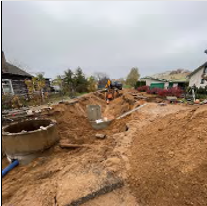
34 pav. Varėnos m. Melioratorių ir Mechanizatorių g. nuotekų šalinimo ir vandens tiekimo tinklų statyba
