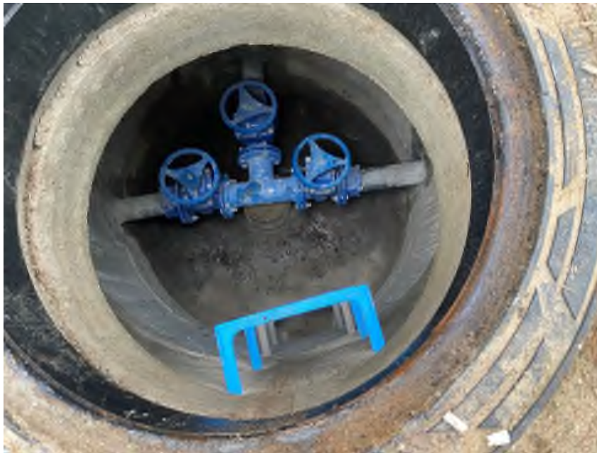
35 pav. S. Varėnos k. Beržų g. vandens tiekimo tinklų statyba
